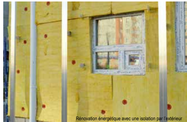
Rénovation énergétique avec une isolation par l'extérieur
